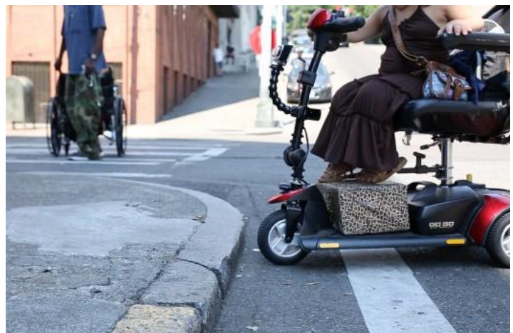
Falta rampa en la acera - Crédito de la foto: Disability Rights
