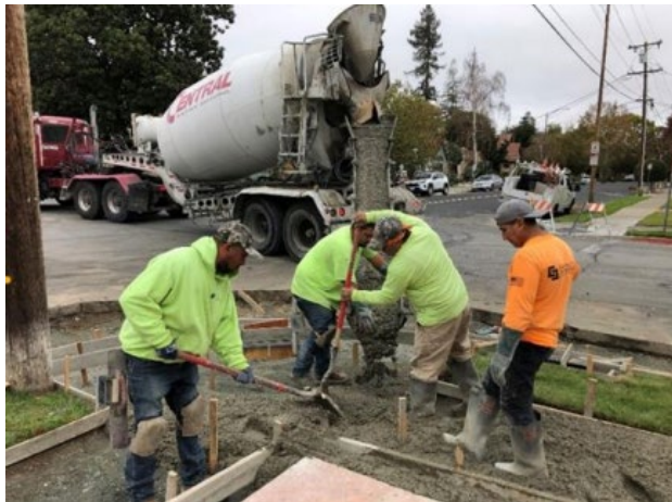
ADA Ramp Install
