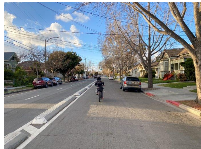
Làn đường mặt tiền hiện hữu trên đường 10/11
