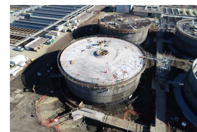
Bể Ủ Khí Sinh Học Ưa Nhiệt đang xây dựng
