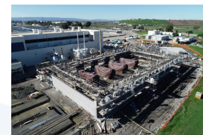
Cơ Sở Động Phát Điện Mới đang xây dựng
