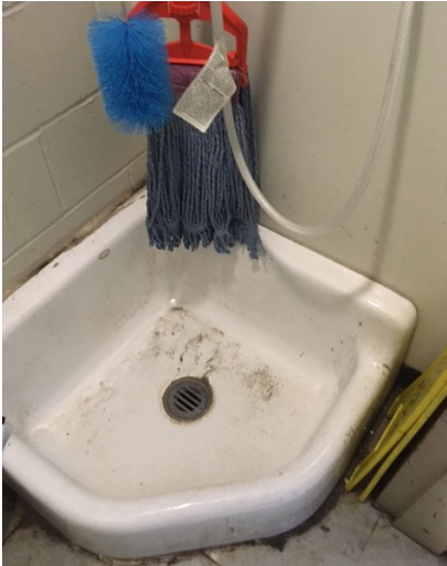
Cống rãnh thoát nước vệ sinh chảy vào trạm xử lý nước.
