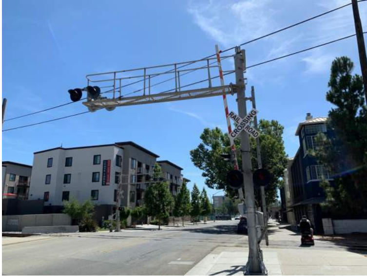
34_E Taylor St Gate2_facing SW.jpg
