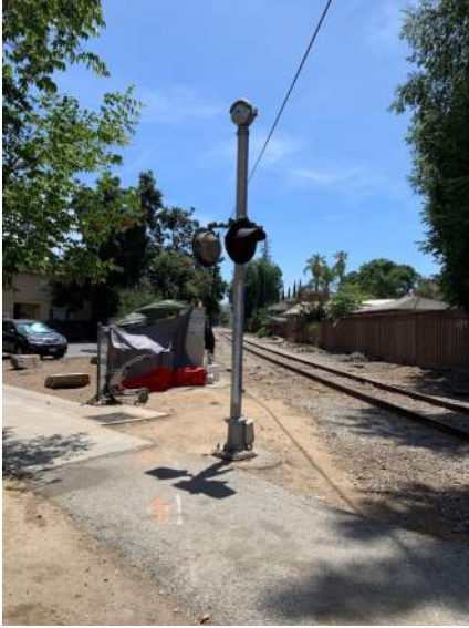
28 N 6 St Signal Pole_facing S.jpg
