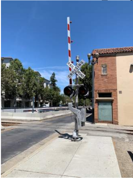
09_N 1 St Northbound Gate_facing N.jpg
