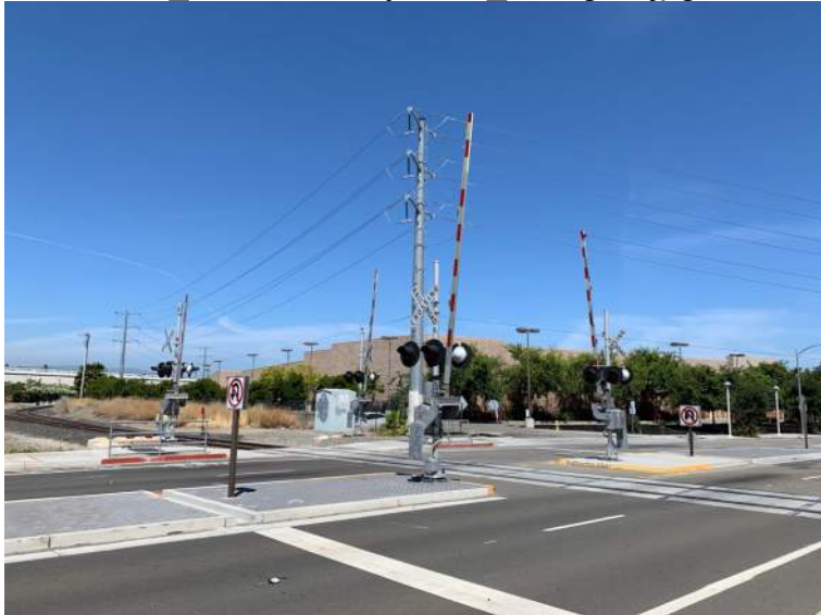
06_Autumn Pkwy Gate_facing W.jpg
