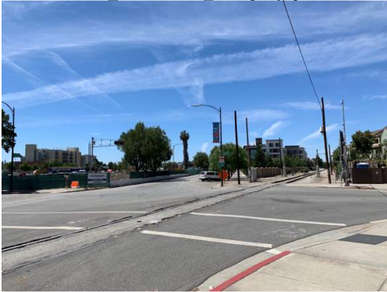
29_N 7 St Gate_facing N.jpg
