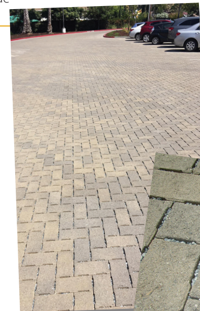
Izquierda: A menudo se utilizan sistemas de pavimento permeable en lugar de hormigón o asfalto.
