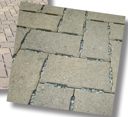
Ảnh bên trái: Hệ thống vỉa hè thấm nước thường được sử dụng thay cho bê tông nhựa đường.
