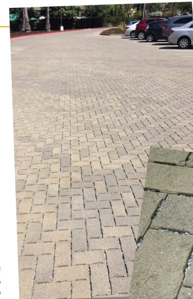
Ảnh bên trái: Hệ thống vỉa hè thấm nước thường được sử dụng thay cho bê tông nhựa đường.
