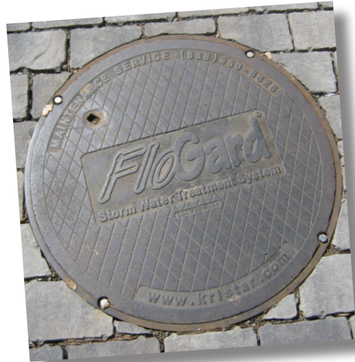
Ảnh trên: Biện pháp Xử lý Nước mưa Cơ học, Nắp hố ga
