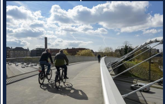
Conectividad Por Bicicletas Sobre Autopistas
